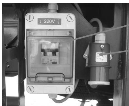
PRISE DE RACCORDEMENT AU RESEAU 220V
